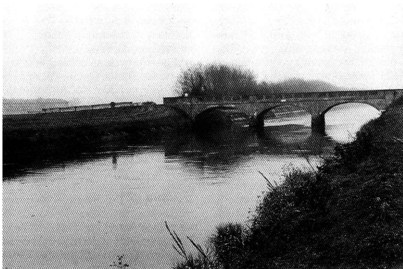
Ponte sul canale Cavour verso Vettigné
